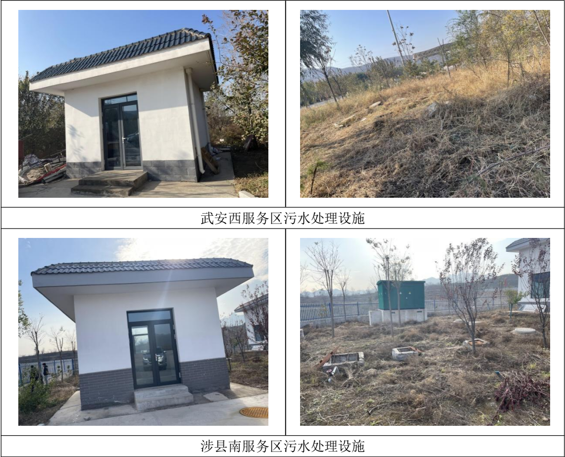
图 7.3-3 沿线服务设施污水处理站
